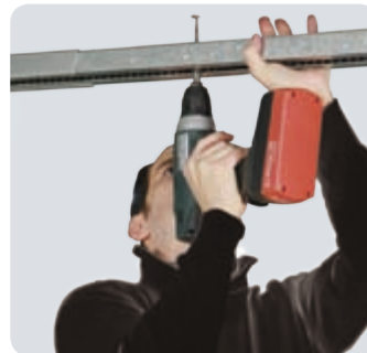
Fixation du rail au plafond en 3 points
